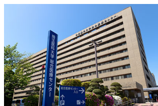
病院外観 本館南側
